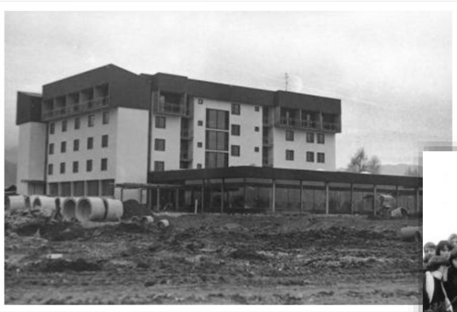
Pogled na novo zgrajen dijaški dom; na sliki je le dijaška stavba, študentski dve sta se gradili kasneje.
